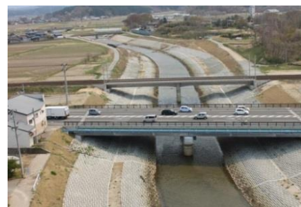
河川改修状況（新城川・秋田市）
