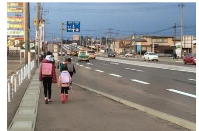
整備された歩道の状況 (国道105号 由利本荘市)
